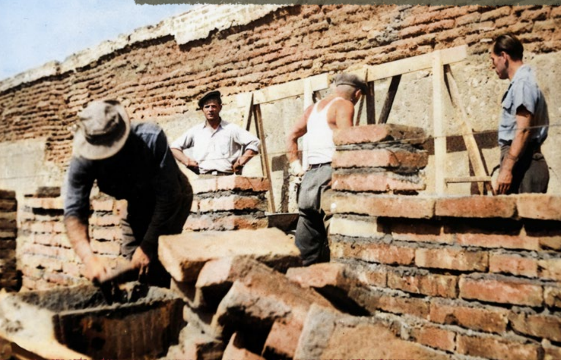
📷 Budowa nowych pomieszczeń na osiedlu dla uchodźców polskich, Santa Rosa, Meksyk, 1944 r. (fot. Instytut Polski i Muzeum im. gen. Sikorskiego w Londynie)
